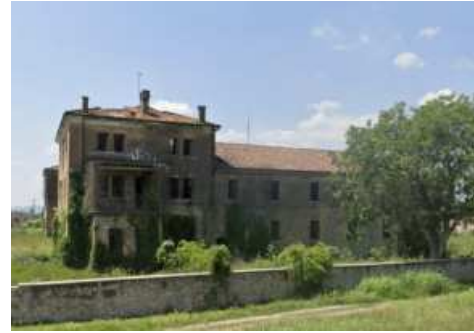
Cartiera Roncajette / Ponte san Nicolò / abbandonata
