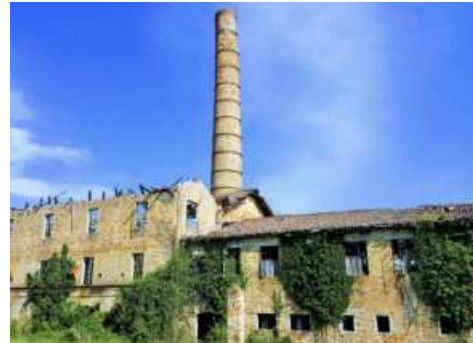
Fornace Cavin / Spinea / abbandonato
