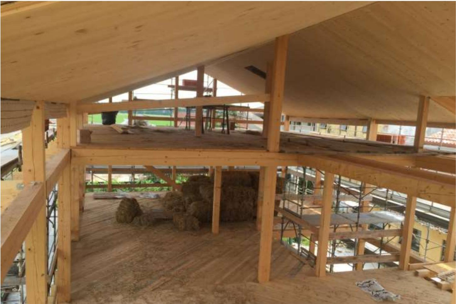
*Edificio con struttura a telaio in legno di abete, vista di solai, pilastri e copertura*
