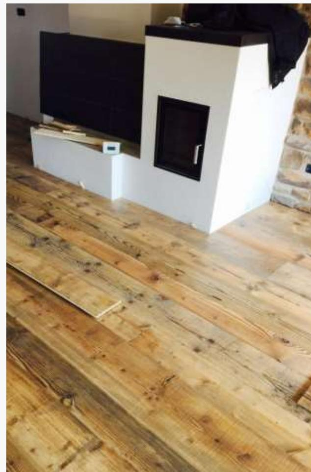
*Rivestimento per pavimentazione esterna e per pavimentazione interna in larice*
