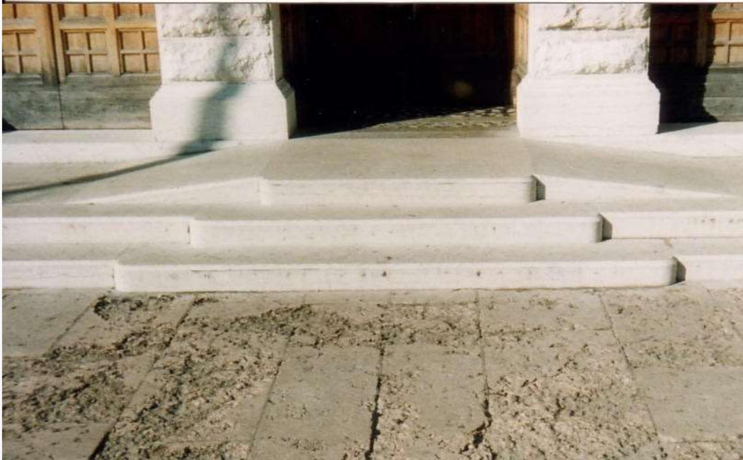
*Marmo Biancone con evidenti problemi di scagliatura: il materiale, dalle caratteristiche tecniche gelive, è stato erroneamente messo in opera esternamente.*
