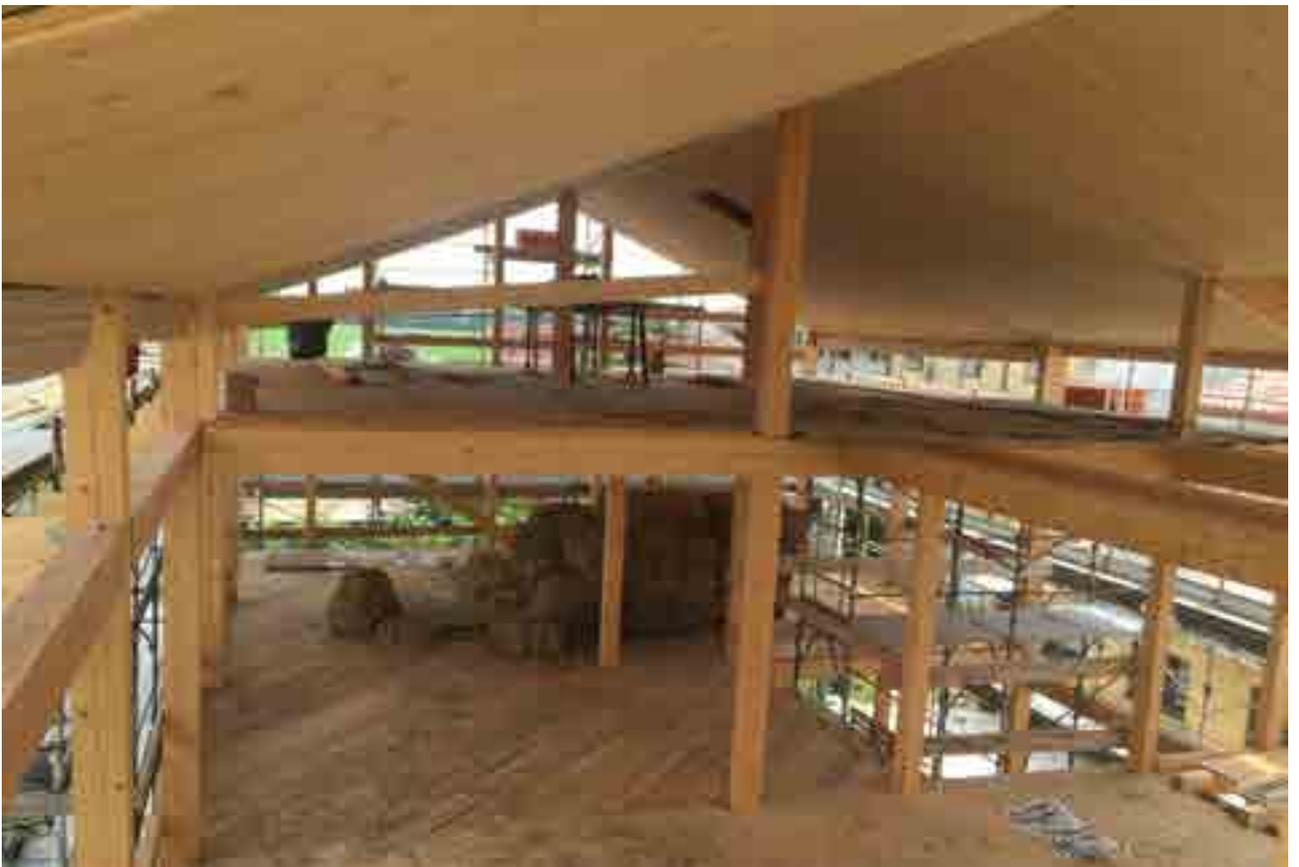
*Edificio costruito con struttura a telaio in legno di abete, vista di solai, pilastri e copertura a falde:
