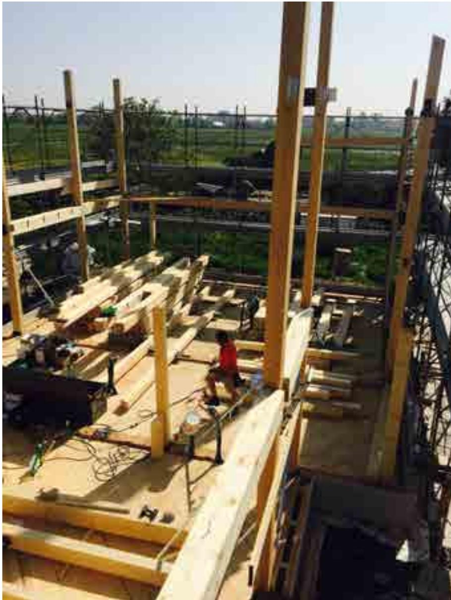
*Edificio costruito con struttura a telaio in legno di abete, vista delle diverse fasi di costruzione:
