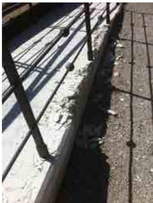
*Marmo Biancone con evidenti problemi di scagliatura. Il materiale, dalle caratteristiche tecniche gelive, è stato erroneamente messo in opera esternamente.*
