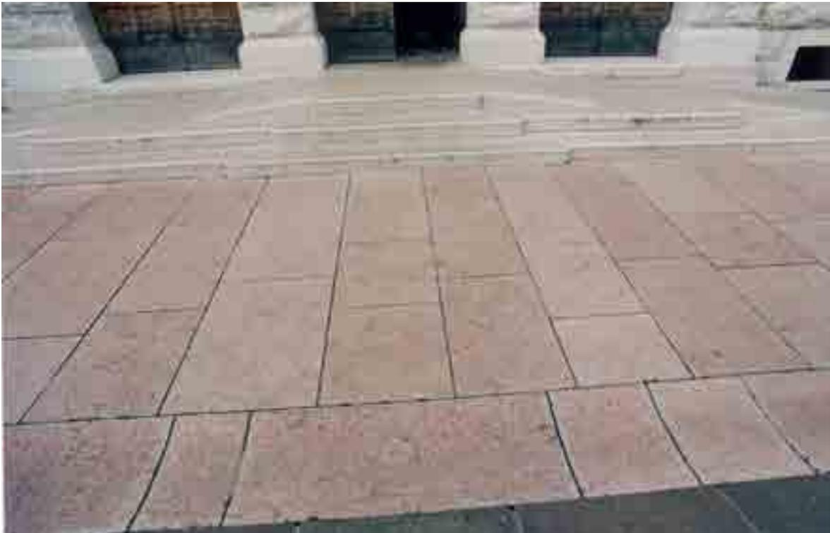
*Nuova pavimentazione in Rosso Ammonitico posta all'ingresso del Municipio di Asiago a sostituzione della precedente degradata in Rosa Asiago.*
